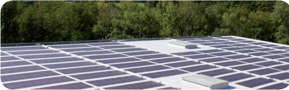
150 kWp Installation in Grenoble (Frankreich) als einlagige Verlegung
