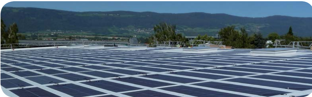
75 kWp Installation in Yverdon-les-Bains als zweilagige Verlegung
